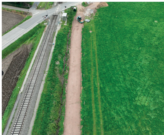
Eindpunt van fase 1 van de fietssnelweg Ronse-Oudenaarde aan de spoorwegovergang in de Weitstraat.
