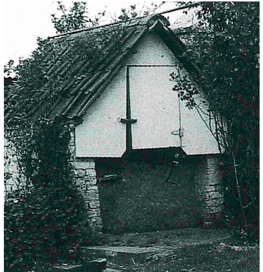
De overdekte gemetste steenput op het erf heeft een diameter van 2 meter en een diepte van 29 meter. Het niveau van het water is steeds gelijk, zo'n 70 cm.
